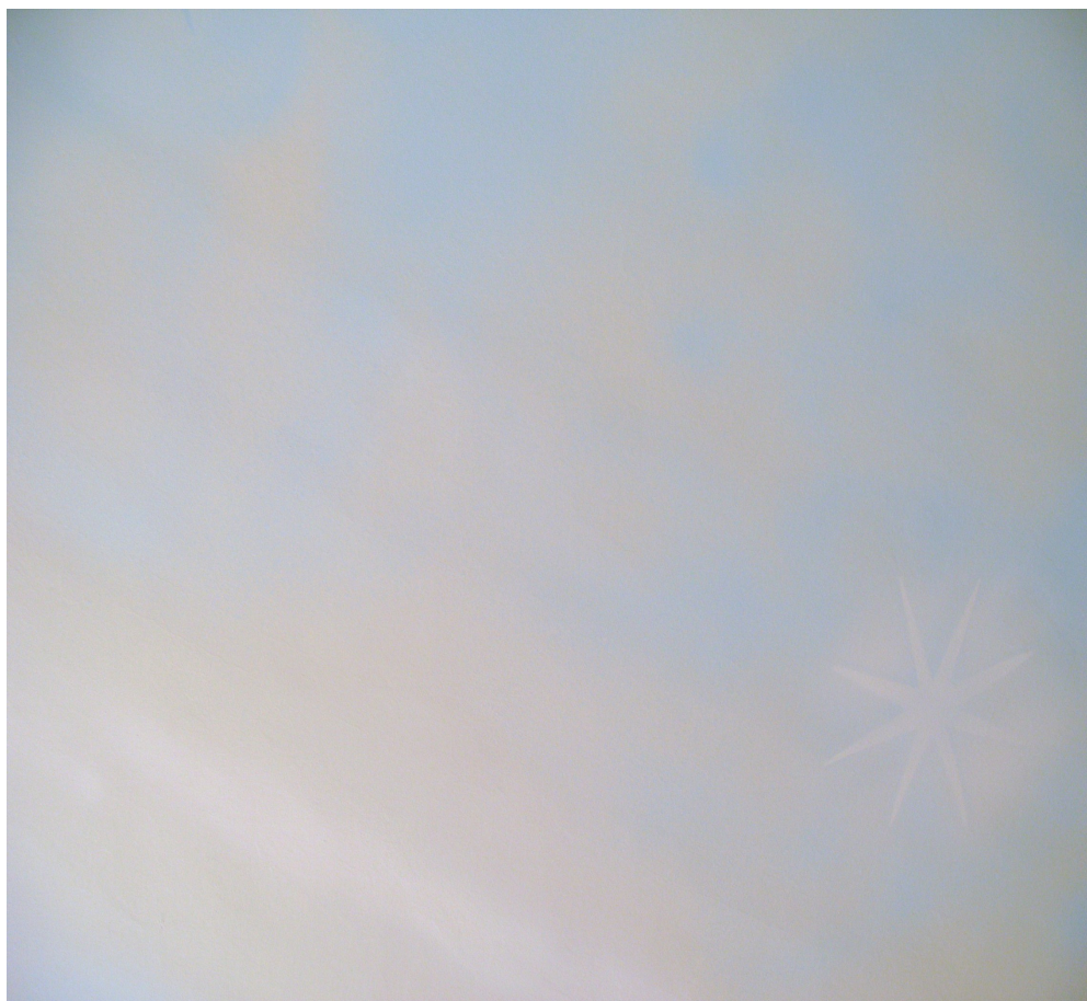
Figura 5. particolare del soffitto.
